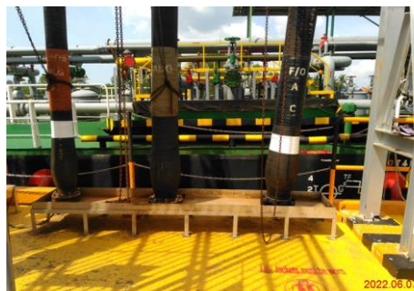
ภาพที่ 11 ถังร่อนน้ำมันที่อาจรั่วหกและวาล์วที่ปิดกั้นน้ำมันปิดตลอดเวลาการขนถ่ายน้ำมันที่ทำ
